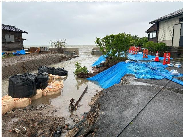
施設横の川の護岸崩落状況
