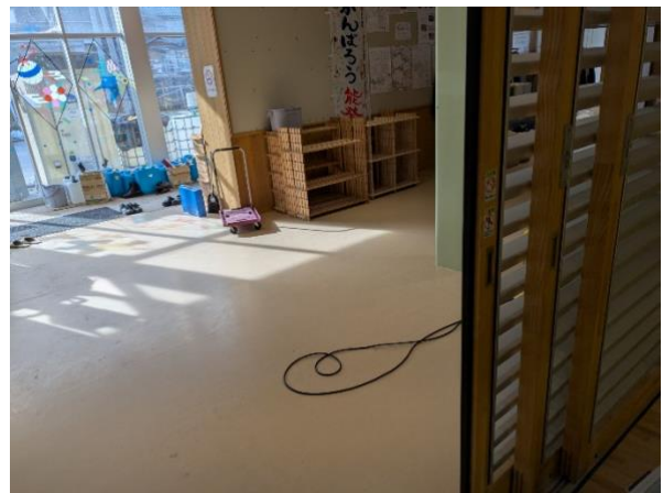
写真4 仕分け物 搬送後の 玄関ホール
